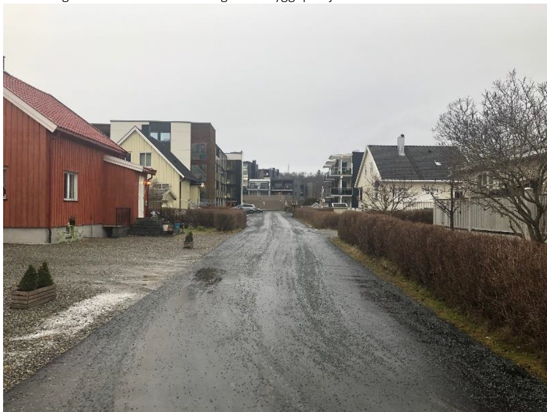
Figur 1: Bilde av Losjevegen i dag mot Løvsetvegen.
